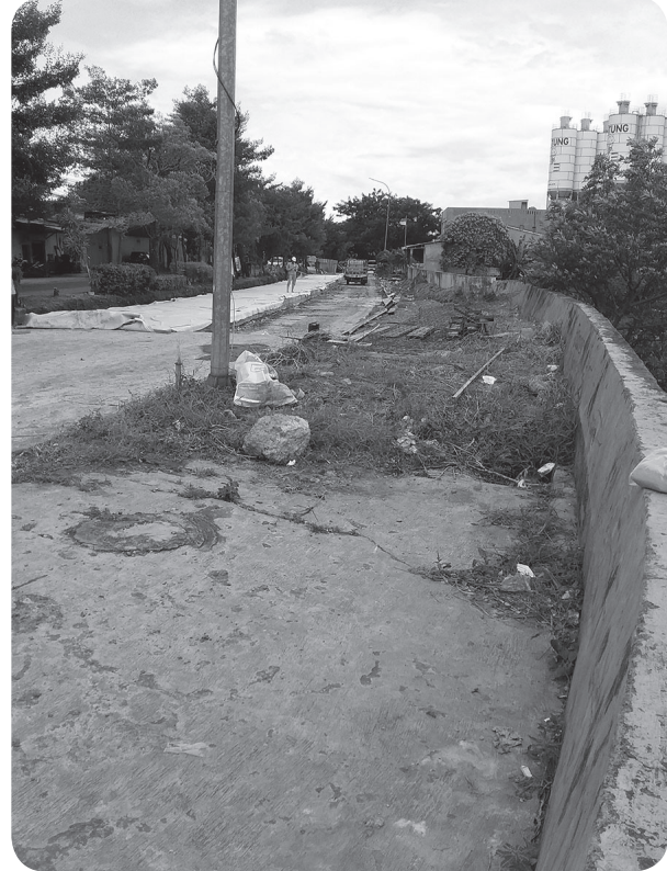
Betonisasi Jalan Baru Cipendawa, Kota Bekasi.
